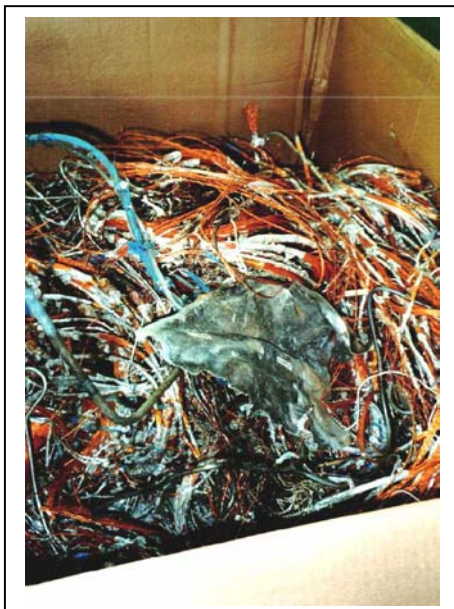
Fig 1.1 : Expertise du réseau de câbles d'un satellite dont la mise en orbite a échoué
